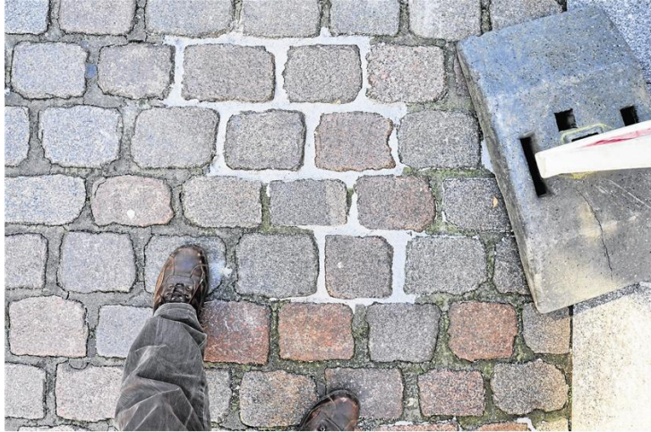
Es geht auch originalgetreu: Für die jüngsten Ausbesserungsarbeiten am Belag der Fußgängerzone setzte die Stadt wieder auf frischen Mörtel. Er braucht nun nur noch etwas Zeit zum Verwittern, damit niemand erkennt, dass hier geflickt wurde. Foto: Grzelak
