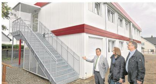
Die Raumcontainer an der Hellweg-Realschule ermöglichen guten Unterricht, sind aber vor allem aus Sicht der Schule nur eine Übergangslösung.
