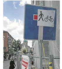
Weiter oben an der „Prünte“-Baustelle wird die Bahnhofstraße zur angeblichen Sackgasse, die aber zu Fuß und per Rad zu passieren sei. Fotos (2): Smulka
