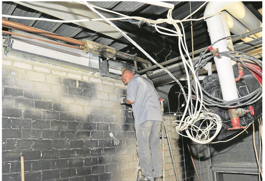
Vor zwei Jahren erst wurden drei neue Lüftungsanlagen in der großen Turnhalle am Ernst-Bartlach-Gymnasium eingebaut, auch die WC-Anlagen wurden saniert. Doch das alte Schulgebäude hat noch weitere Mängel, die behoben werden müssen. Foto: Archiv
