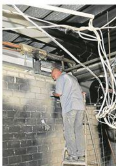
Schon vor zwei Jahren wurde am EBG einiges saniert.
