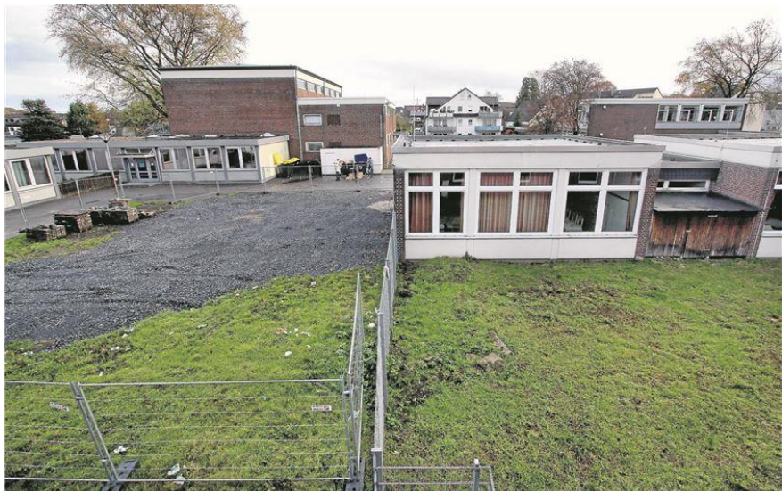
Noch in diesem Jahr wird auf dem eingezäunten Bereich links ein weiterer Schulcontainer an der Hellweg-Realschule aufgestellt werden. Nur so können die Sanierung und die Erweiterung im laufenden Schulbetrieb erfolgen. Foto: Archiv
