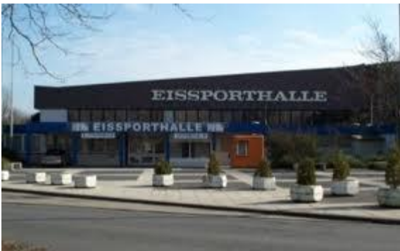
Die Eissporthalle in Unna.
