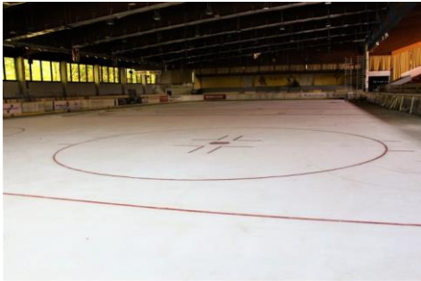
Die Eishalle Unna bei der öffentlichen Begehung am 16. 7.
