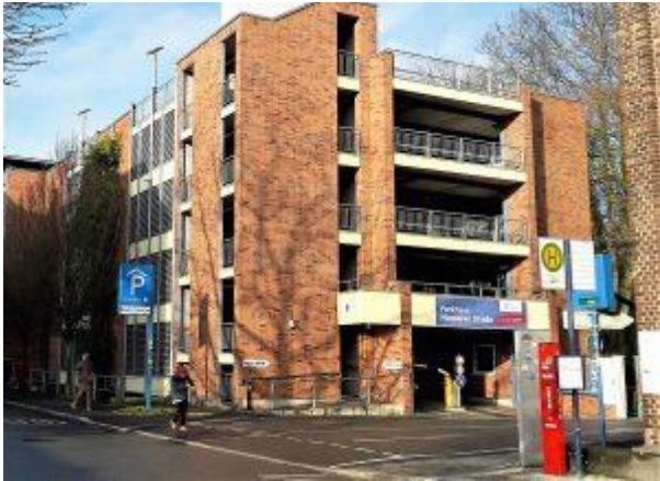
Das Parkhaus an der Massener Straße. (Fotoquelle
