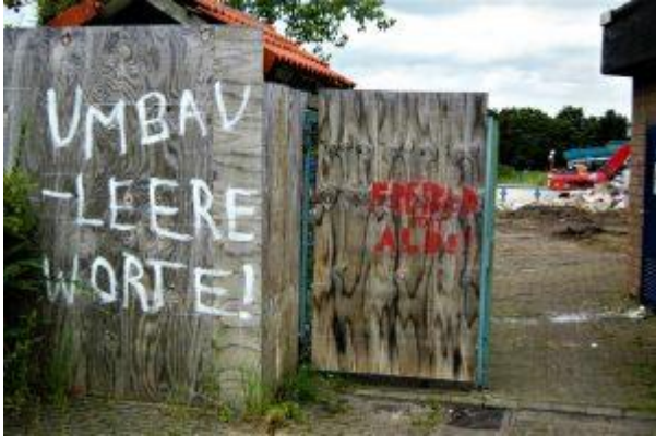
Abriss des Freizeitbades Massen. (Archivbild
