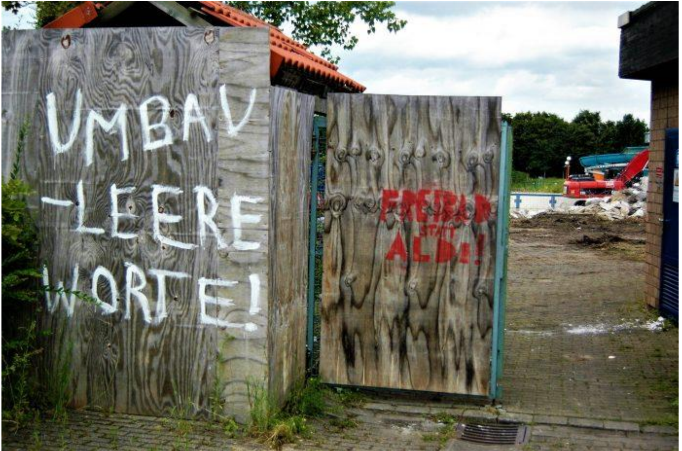
Abriss des Freizeitbades Massen. (Archivbild Rundblick)
