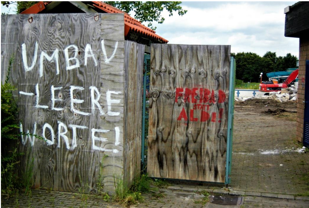
Abriss des Freizeitbades
