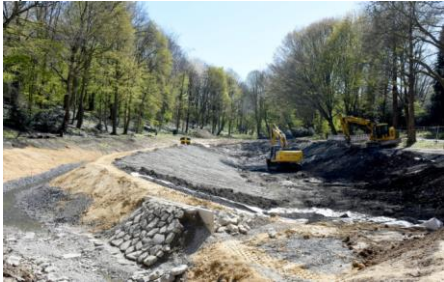
Baufortschritt am 1. Teich im Bornekamp. (Foto Stadt Unna)
