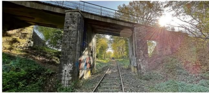
Die Loerweg-Brücke überspannt die Bahnstrecke Unna-Fröndenberg. Die Brücke soll nun abgerissen werden.
